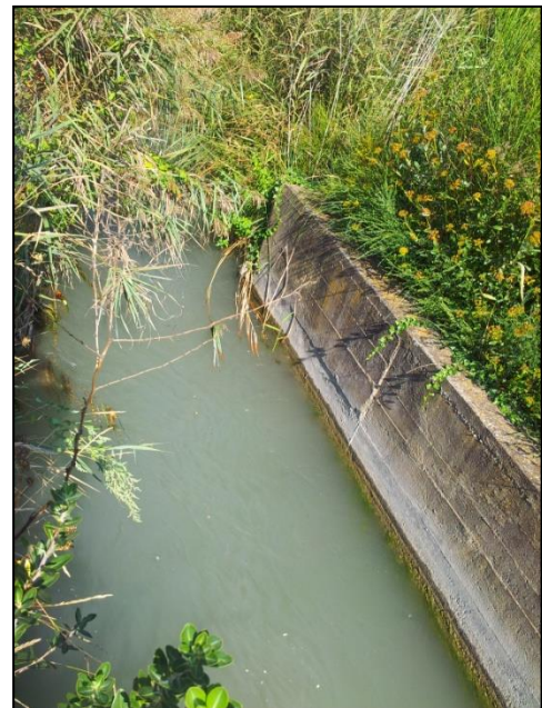
Figure 20 : Photos des protections bétons autour des canaux (Source : Photos SNC Lavalin 2013)
