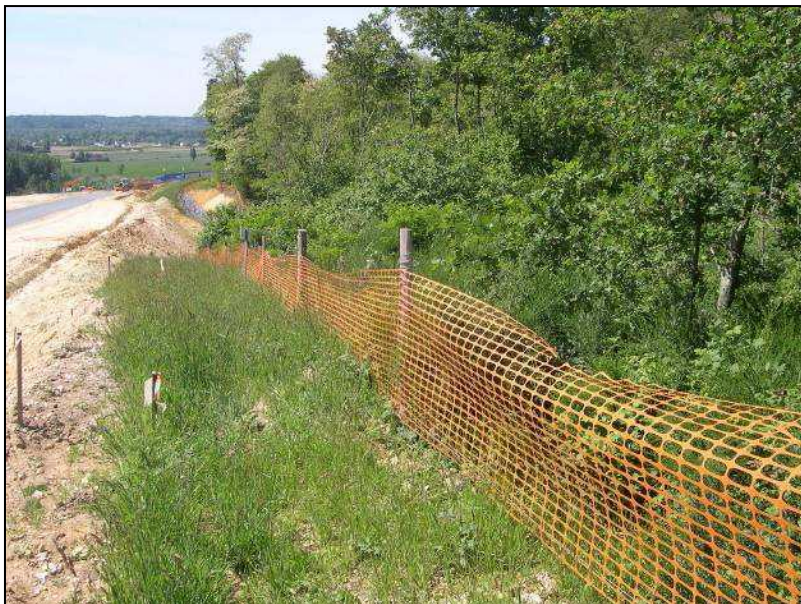
Figure 40 : Exemple de barrière PVC à mettre en place
