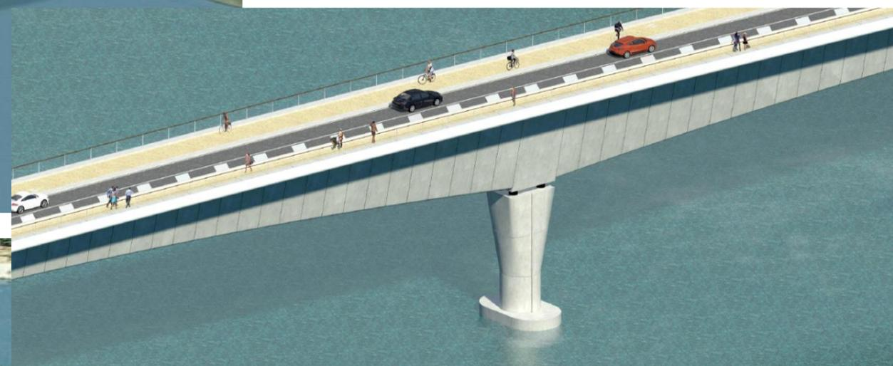
Figure 45 : Variante 5: Béton précontraint construit par encorbellement
