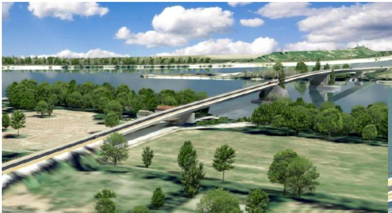
Figure 48 : Variante 4: Caisson mixte à hauteur Variable
