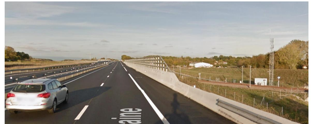
Figure 18 : Exemple d'écran anti-déversement pour le franchissement de la LGV SEA par l'A10 à hauteur de Fontaine-le-Compte – source : image street-view
