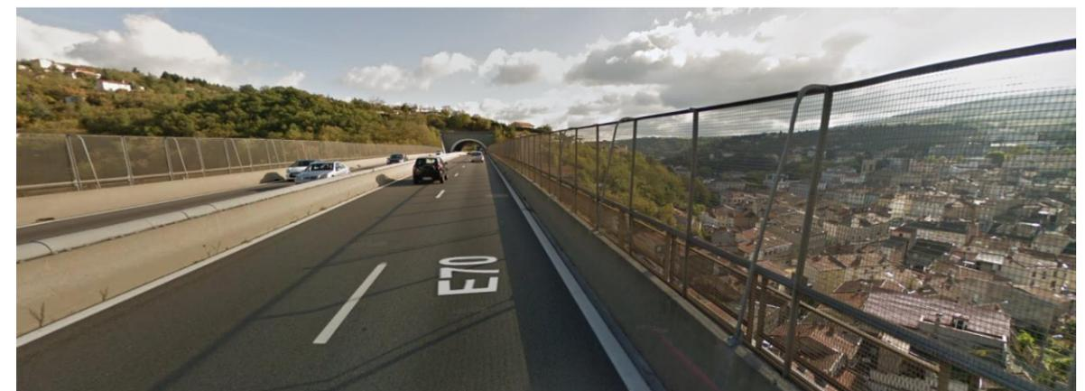
Figure 19 : Exemple d' « écran de retenue d'objet » sur le viaduc de l'A57 à Rive-de Gier - Source : image street-view
