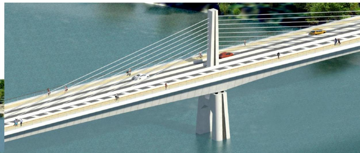
Figure 46 : Variante 1: Précontrainte extradossée
