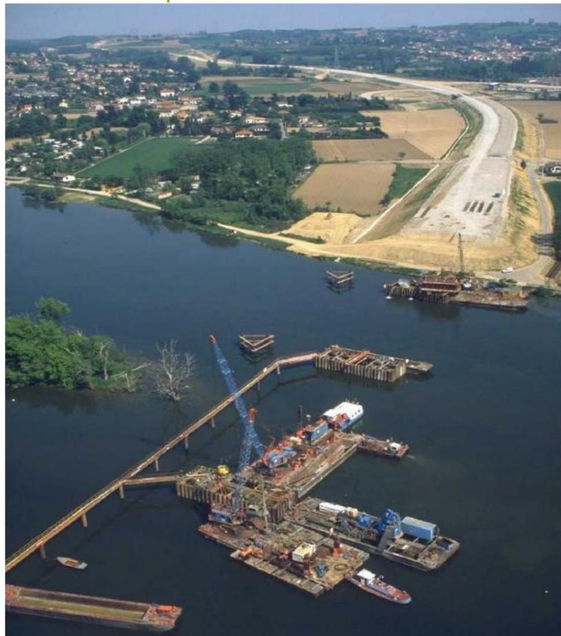
Photo 5 : Travaux de fondations du viaduc de la Saône
