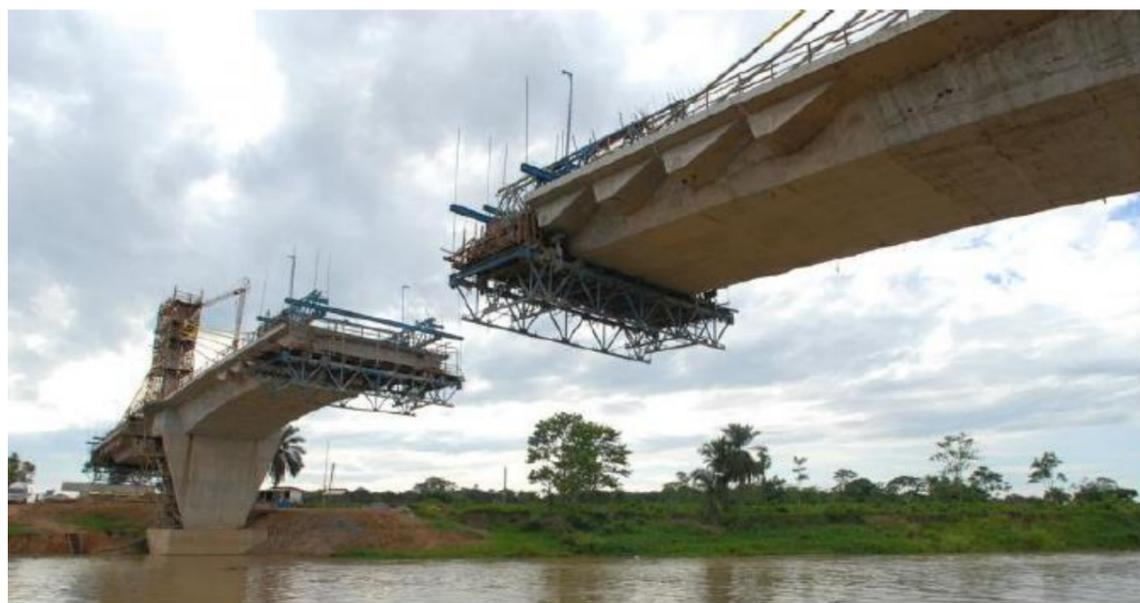
Photo 6 : Construction par encorbellements successifs d'un tablier en caisson béton précontraint avec des voussoirs coulés en place à l'aide d'un équipage mobile
