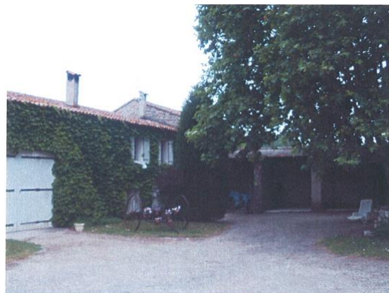
Façade est des bâtiments
