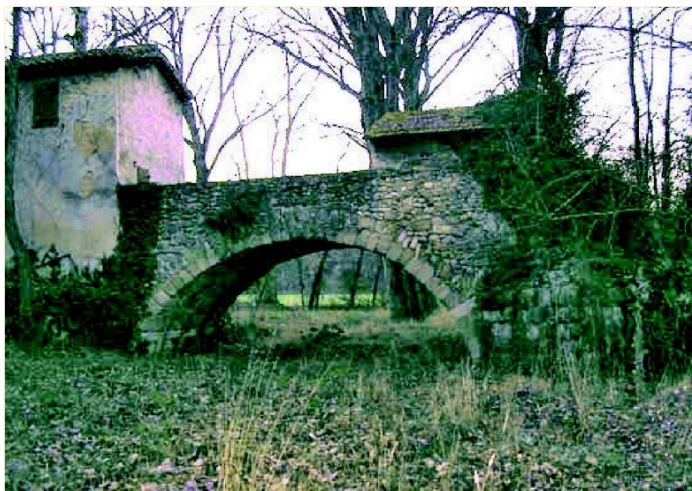
L'ancien Pont de Bachasson - source : GEI
