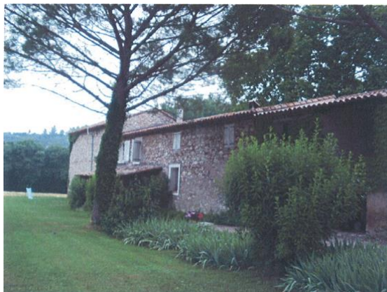
Façade ouest des bâtiments
