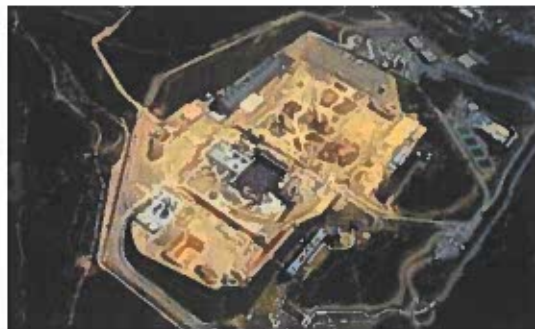
Plateforme ITER – source : www.iter.org
