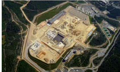
Plateforme ITER – source : www.iter.org
