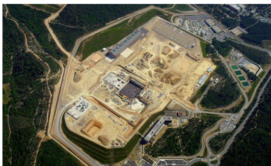
Plateforme ITER – source : www.iter.org
