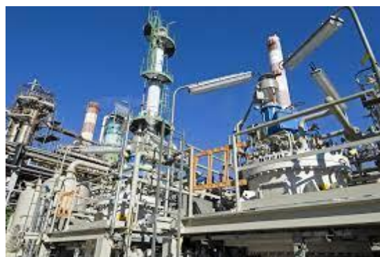
©usinouvelle – Raffinerie Fos
