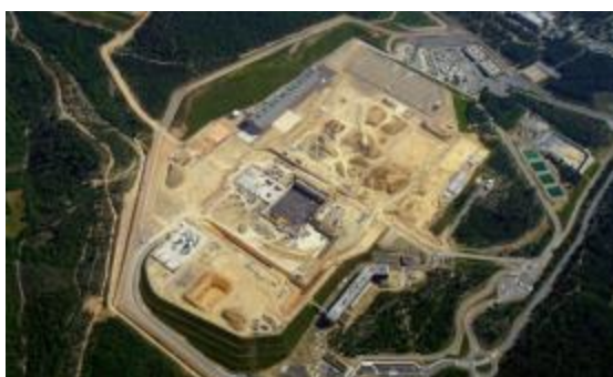
Plateforme ITER – source : www.iter.org
