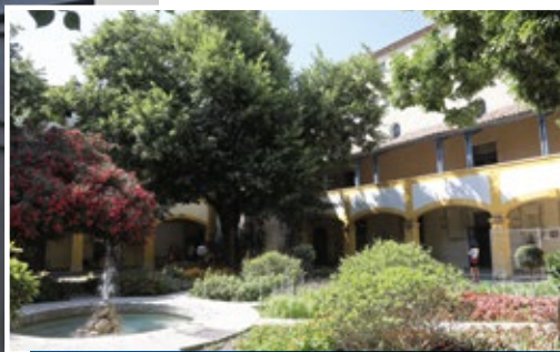
L'antenne universitaire située à l'Espace Van Gogh a vu ses travaux de réfection terminés en 2023
