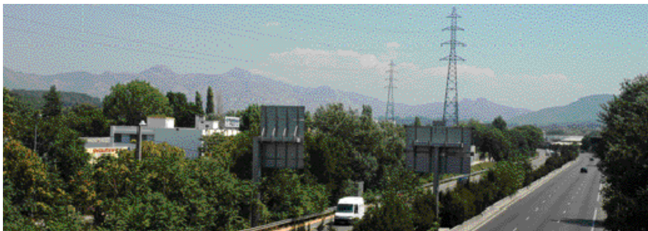
Le couloir industriel à La Penne-sur-Huveaune
