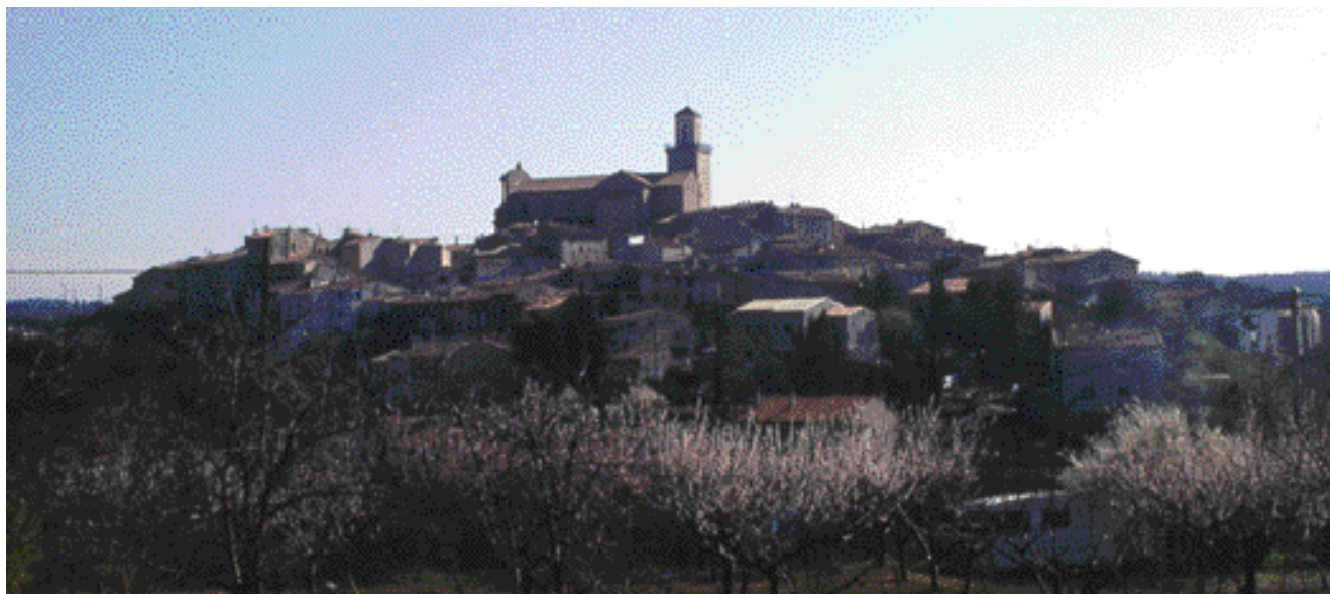
Le village perché de Fuveau est dominé par son église vue depuis la RD 56 E au Nord, printemps 1998
