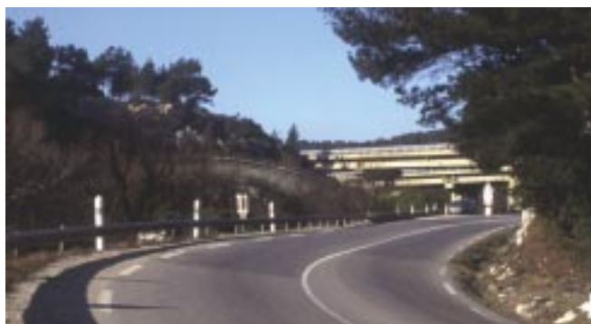
La RN 7 longe les cluses de l'Arc franchies par l'A 8 et par le siphon du canal de Provence
