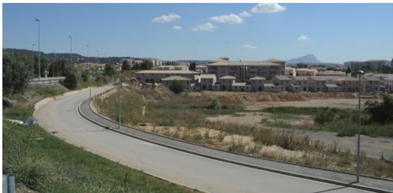
Chantier en cours sur la limite Ouest du Jas-de-Bouffan
