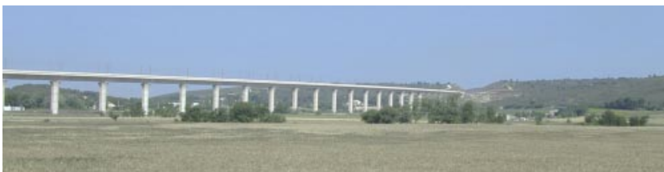
Le viaduc du TGV enjambe la plaine d'Eguilles au Pontails
