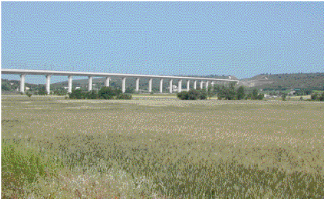
Unité de paysage du pays d'Aix : le viaduc du TGV à Eguilles
