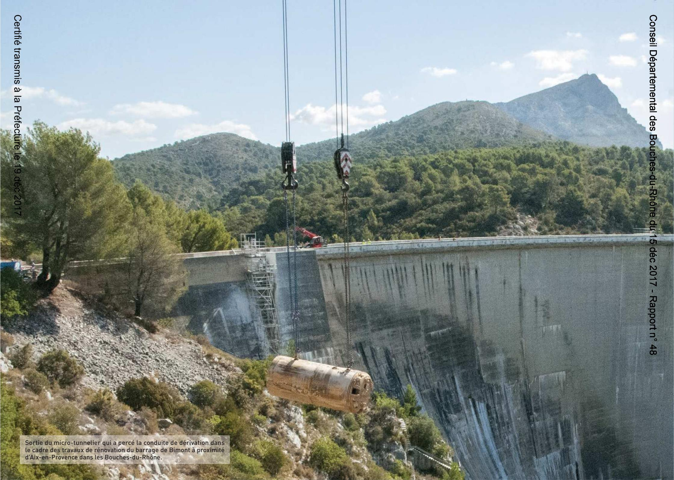
Sortie du micro-tunnelier qui a percé la conduite de dérivation dans le cadre des travaux de rénovation du barrage de Bimont à proximité d'Aix-en-Provence dans les Bouches-du-Rhône.
