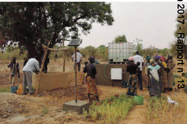
Le projet « Providence by SCP », appareil de potabilisation autonome et fonctionnant à l'énergie solaire, est soutenu par l'Agence de l'Eau Rhône Méditerranée Corse et la Ville d'Aix-en-Provence. La SCP en installe aujourd'hui notamment en Afrique et dans les Caraïbes. Les interventions en Afrique, comme sur les photos ci-dessus au Burkina-Faso, sont organisées en partenariat avec l'ONG marseillaise MPA.
