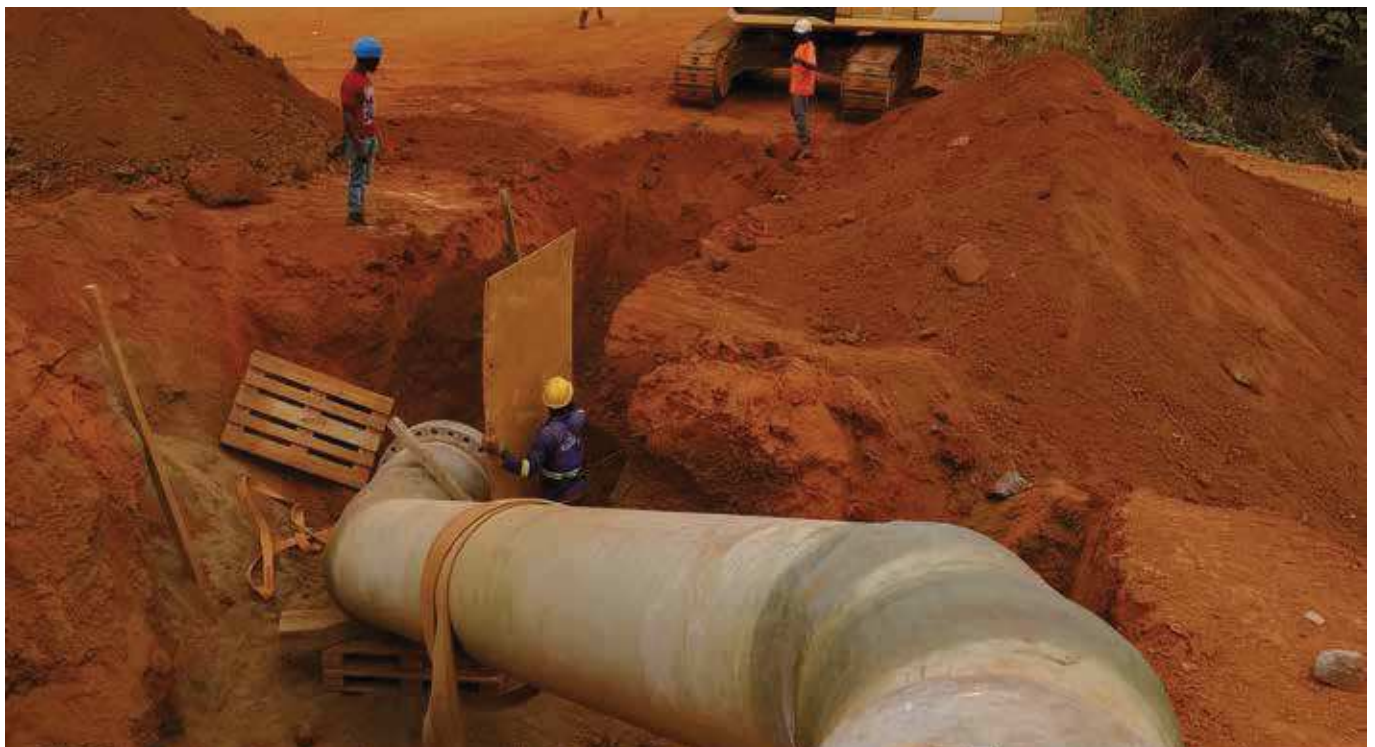
Chantier pour la SOSUCAM, au Cameroun
