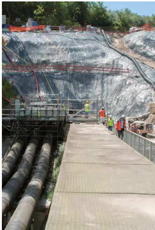
Rénovation du tunnel de la Roquette, dans le Var
