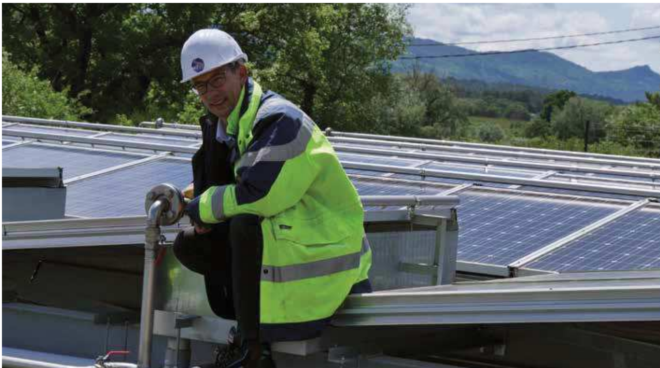
Projet Canalsol en partenariat avec le CEA, dans le Var
