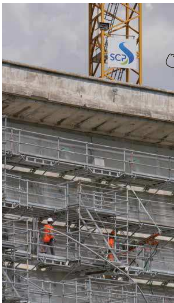
Échafaudages du barrage de Bimont
