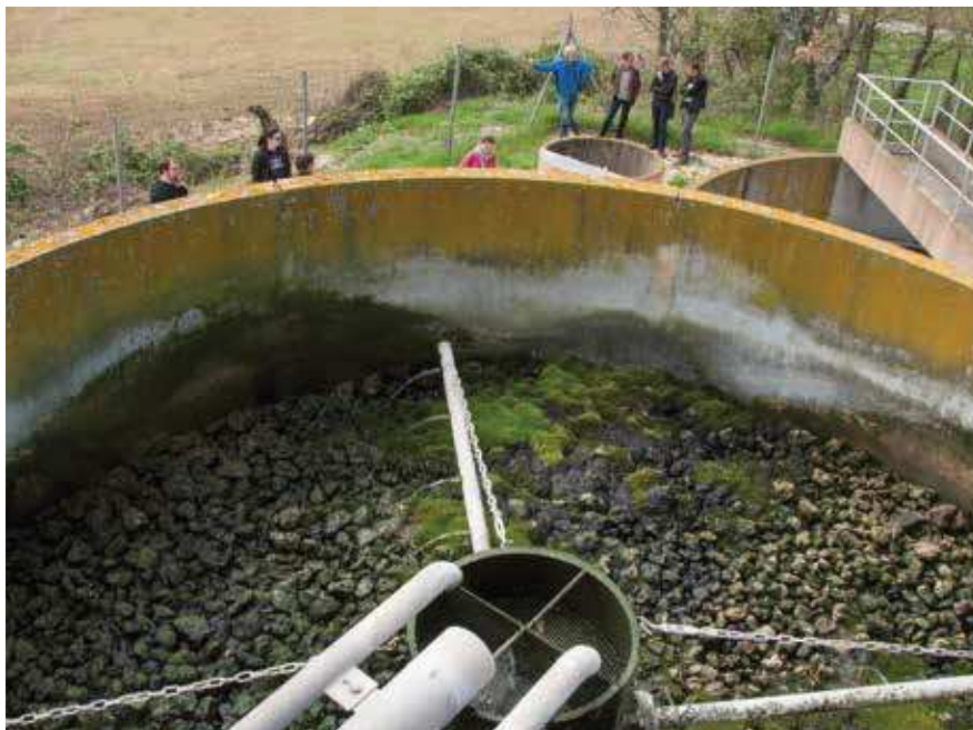
Expérimentation de la réutilisation des eaux usées, dans le Vaucluse
