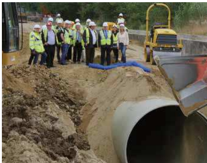
Visite de chantier de la minicentrale d'Eyguières, dans les Bouches-du-Rhône
