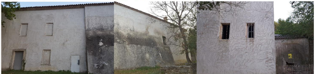
Vue Nord : A gauche (en gris foncé), porte du RDC permettant l'accès à la salle du 1 er étage et à l'étable, à droite, détail des 2 fenêtres utilisées par les chauves-souris pour sortir; la fenêtre de gauche est majoritairement utilisée
