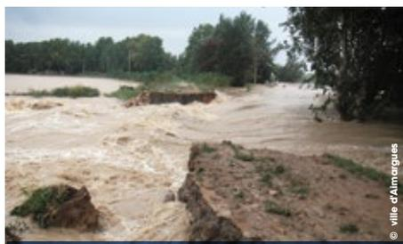
Exemple d'une brèche formée dans une digue avant les travaux
